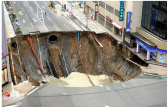
博多駅前の陥没事故の様子
