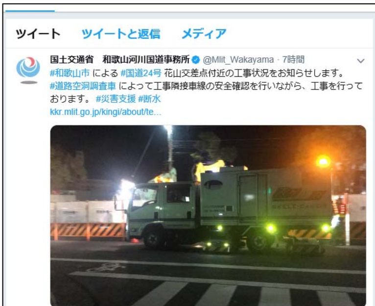
※2 和歌山河川国道事務所ツイッターより スケルカによるモニタリング調査の様子
