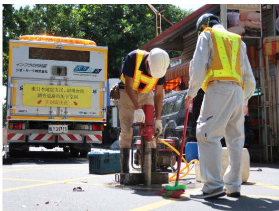
空洞発見箇所での詳細調査
