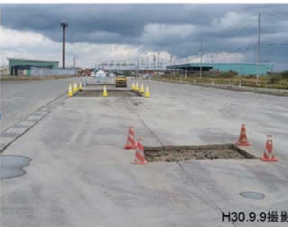
取壊し・掘削後
