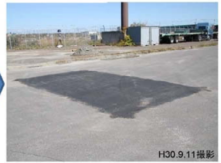
舗装の復旧・仮復旧
