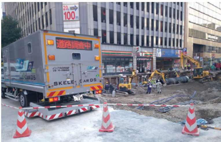
復旧前の安全確認調査の状況(二〇一六年のJFR博多駅前道路の陥没現場)
