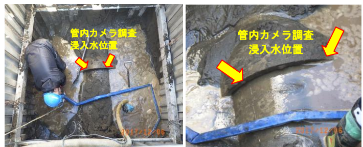
図-4 開削状況写真
