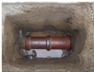
図-10 下水道管布設状況写真
