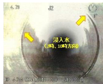
図-6 管内カメラ状況写真
